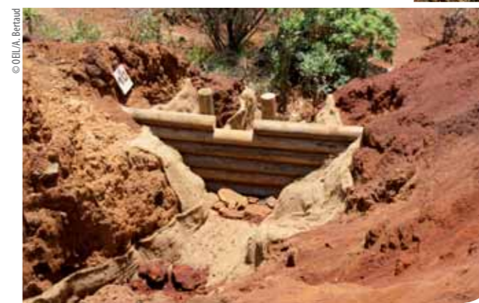
Le gabion, ouvrage de réhabilitation des zones dégradées
